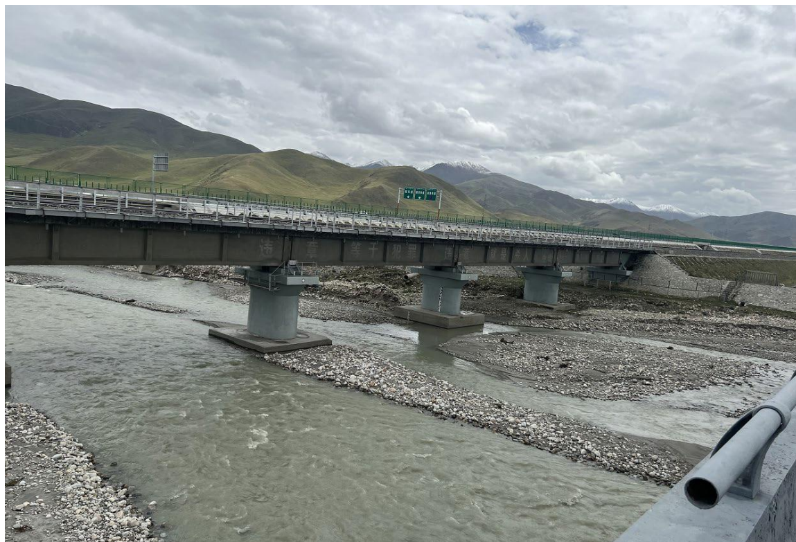
图 1.1-6 堆灵村铁路桥实景
